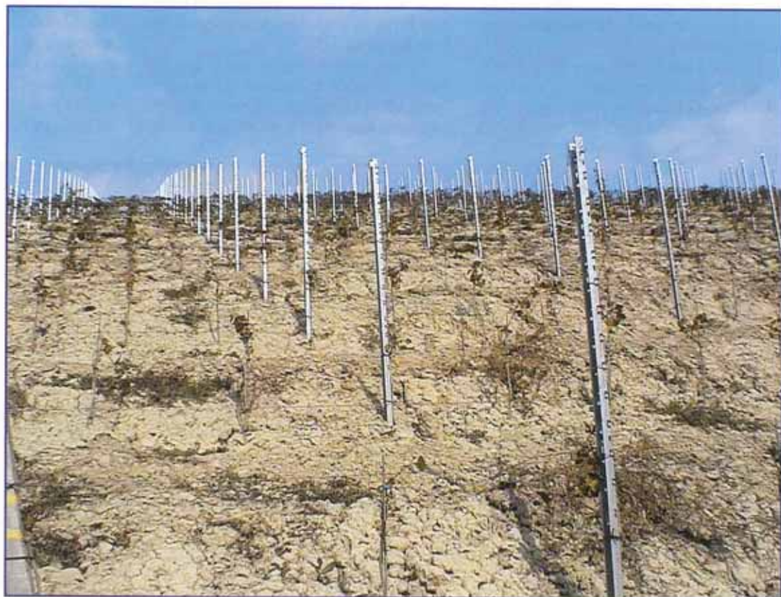
Nuovo impianto con pali di ferro zincato. New plant with zinc-plated iron poles.
