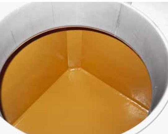
**Foto 4** Serbatoio in cemento con rivestimento con resine epossidiche (CLC)
