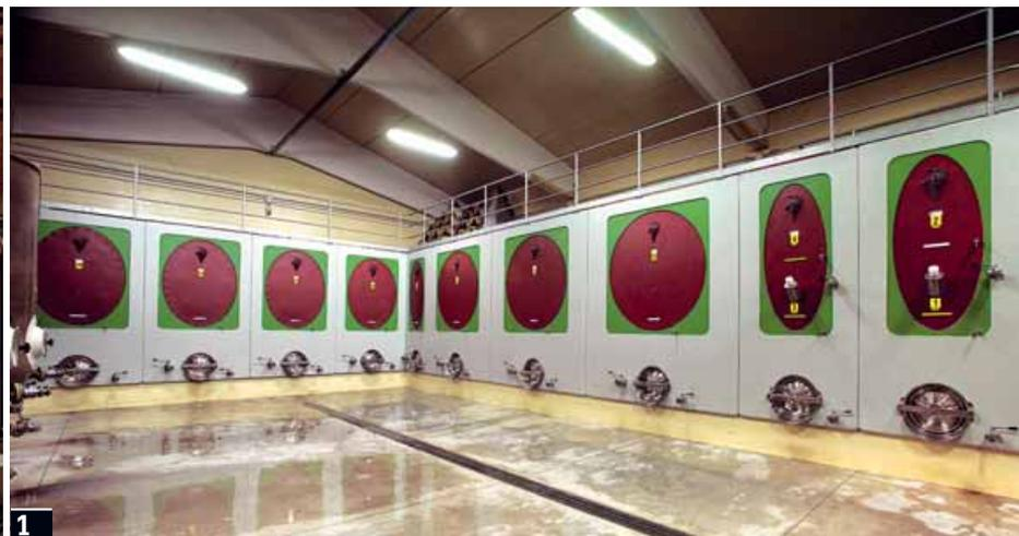
**Foto 1** Serbatoi in cemento costruiti sul posto. **Foto 2** Moderna cantina con serbatoi in cemento (CLC)
