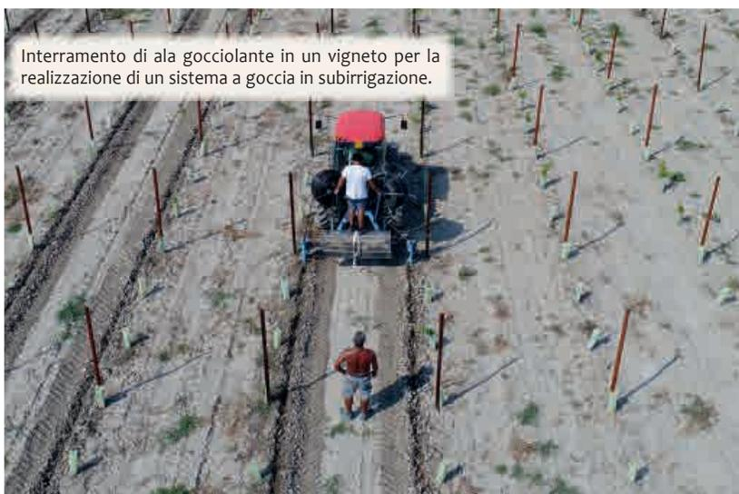
Interramento di ala gocciolante in un vigneto per la realizzazione di un sistema a goccia in subirrigazione.
