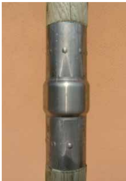
Rinforzo in acciaio inox applicato su un palo di legno.
