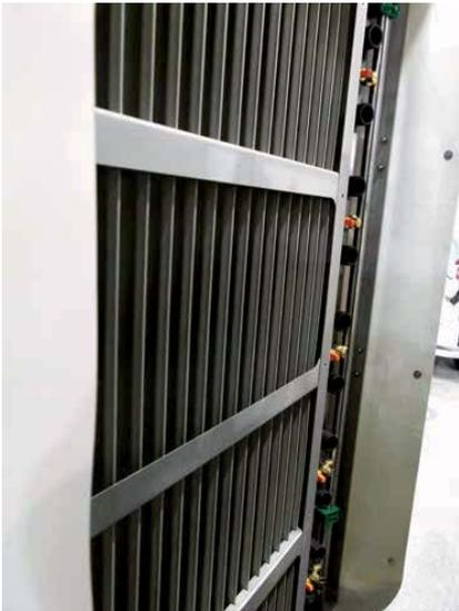
UN ESEMPIO DI SCHERMO DI INTERCETTAZIONE DELLA DERIVA: IN QUESTO CASO È FORMATO DA UNA SERIE DI LAMELLE
